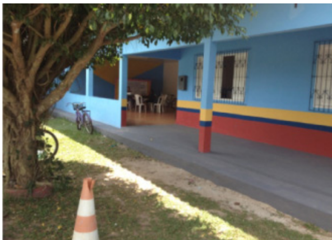
Fotografia 09 - CRAS Propira, Castanhal (PA), vista da área coberta. Fonte: acervo do Ministério Público do Estado do Pará
