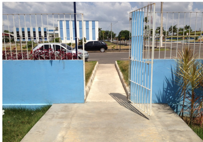
Fotografia 10 - CREAS, Castanhal (PA), portão de entrada. Fonte: acervo do Ministério Público do Estado do Pará
